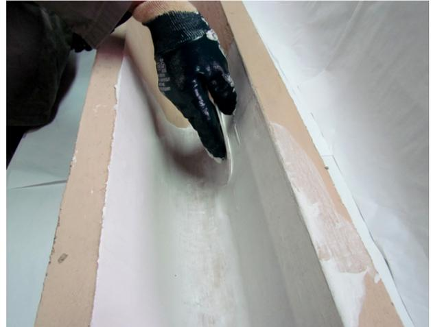
Termalcoat T e P têm excelente reflexão térmica e resistência dielétrica, propriedades que aumentam ainda mais o seu campo de aplicação. Quando expostos à temperaturas acima de 871°C, ganham maior poder de proteção em razão da liga cerâmica que se forma.
